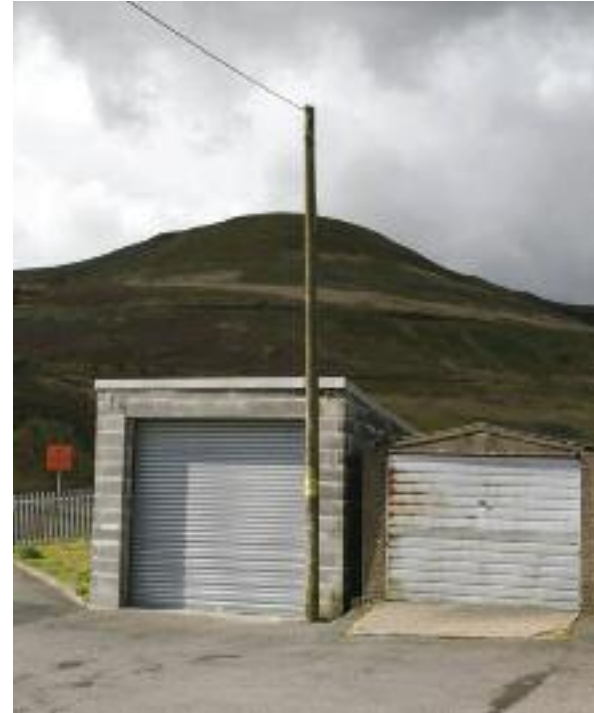
Park Road Paul Cabuts
